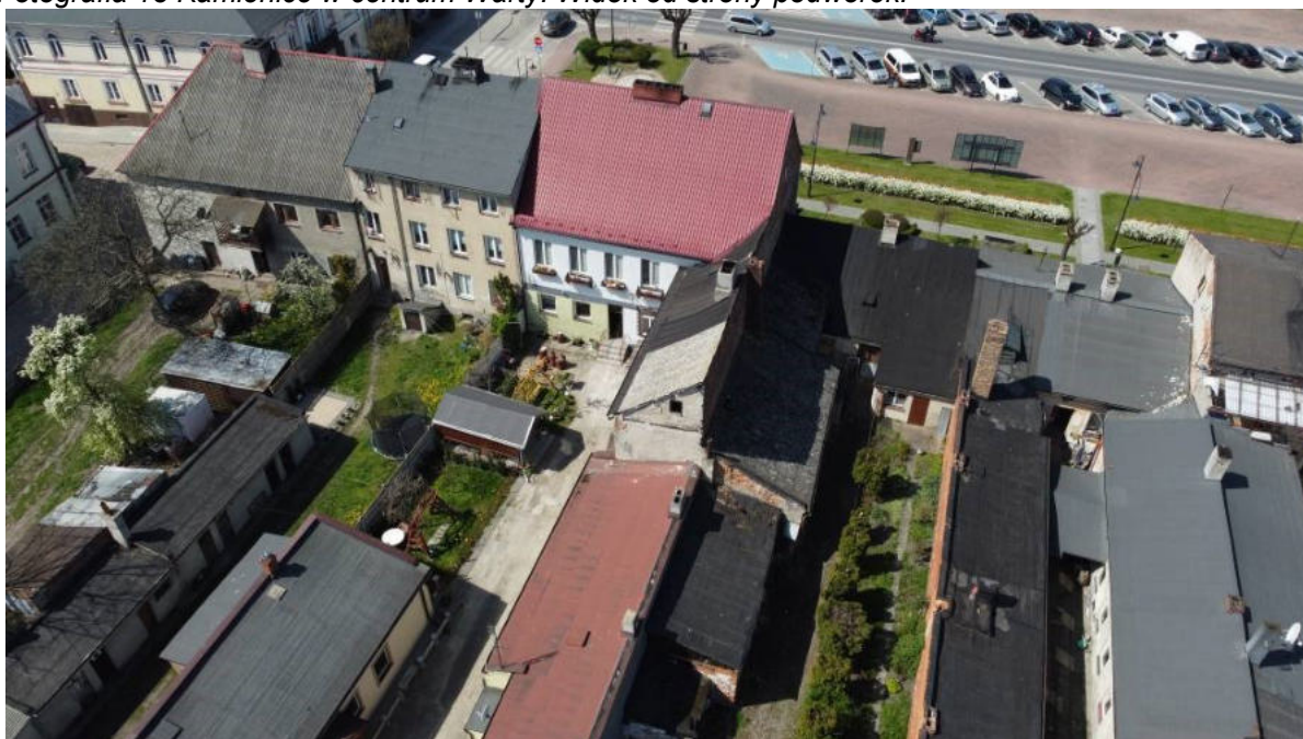
Fotografia 13 Kamienice w centrum Warty. Widok od strony podwórek.
