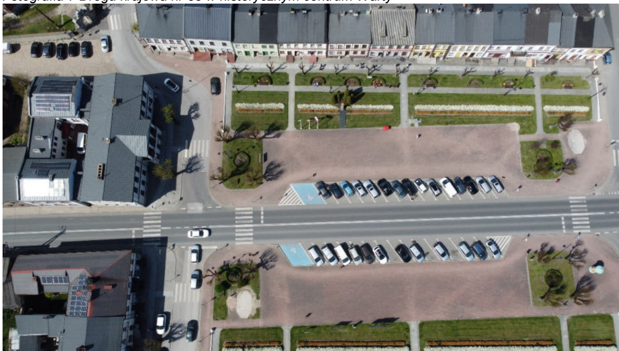
Fotografia 7 Droga krajowa nr 83 w historycznym centrum Warty
